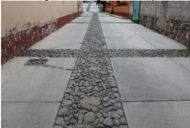
a) Concreto con empedrado
